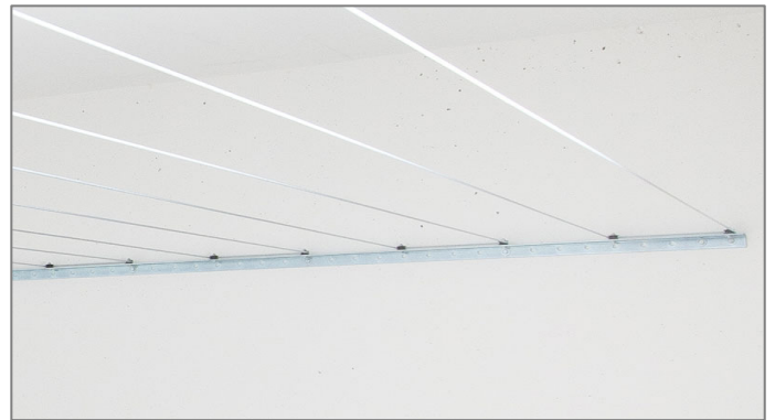
Winkelschiene an der Wand montiert
